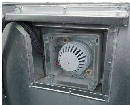
Czujka dymu CD – przykład montażu
